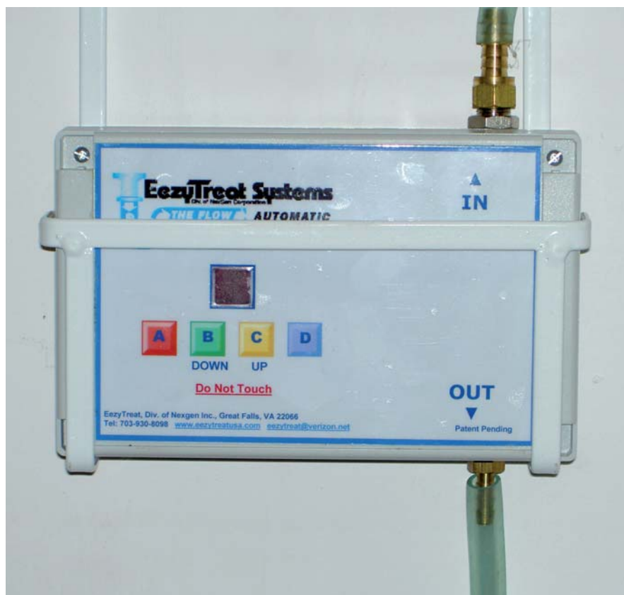
Rys. 13. Saymon-Eezytreat to system mikrobiologiczny przeznaczony do rozkładu tłuszczu w kanalizacji
